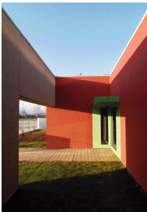
La corte di ingresso della scuola.
