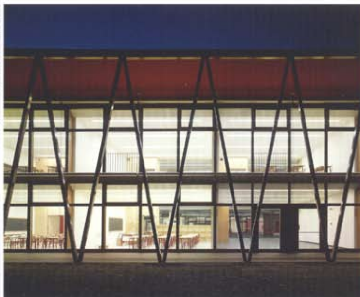
Nel 2009 è stato completato il nuovo edificio della scuola elementare di Ponzano. Le colonne disposte a V che, distanziate dalla facciata, sostengono il tetto sono l'elemento distintivo della struttura.
