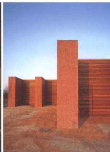
Le pareti dell'impianto di trattamento dell'acqua a Venezia sono realizzate in calcestruzzo rosso.
