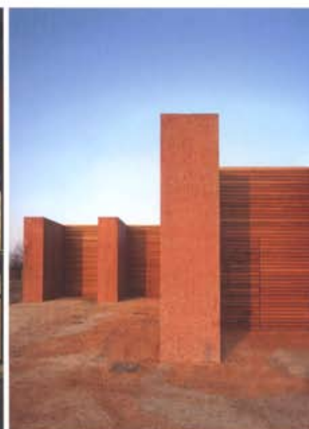
Le pareti dell'impianto di trattamento dell'acqua a Venezia sono realizzate in calcestruzzo rosso.
