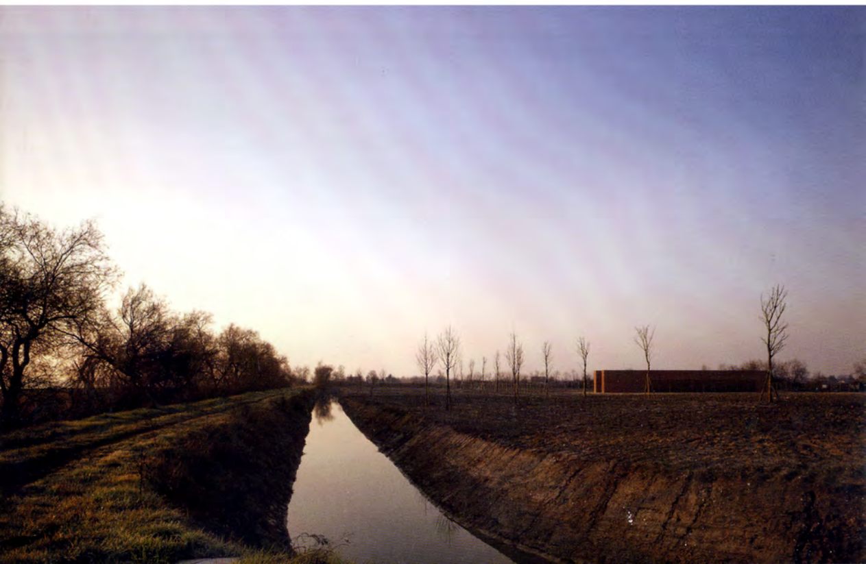
13. Il depuratore nel paesaggio dell'isola
