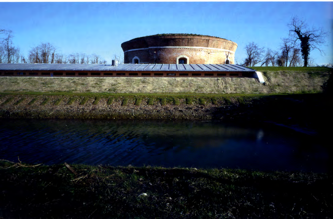
4. Il 'terrapieno contemporaneo' che ospita i servizi alla Torre Massimiliana
