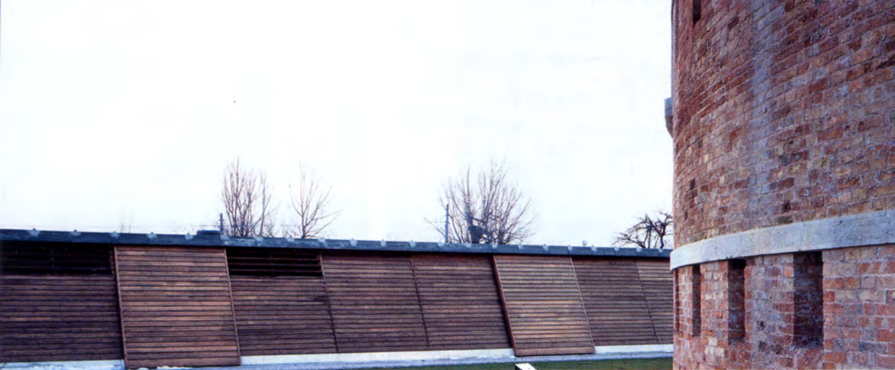
9. Il 'terrapieno contemporaneo' che ospita i servizi alla Torre Massimiliana, vista interna
