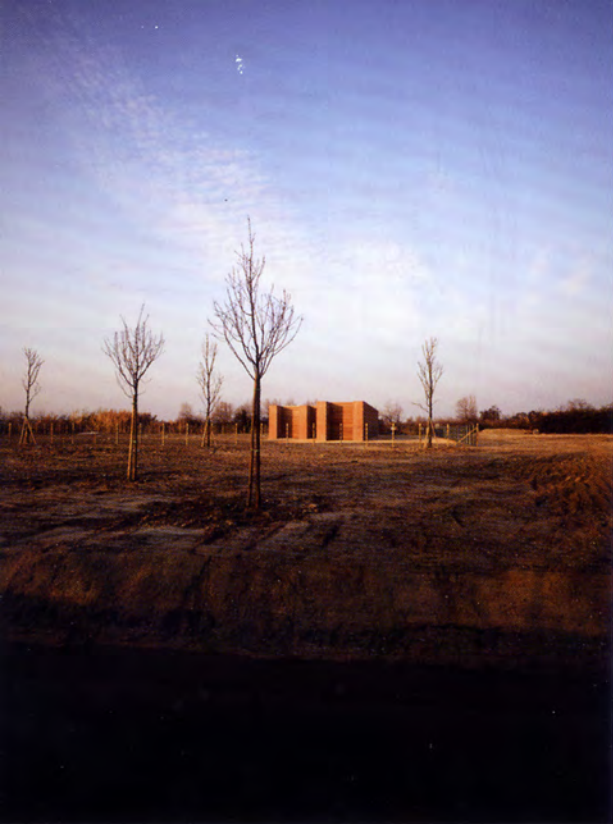
14. Il depuratore nel paesaggio dell'isola
