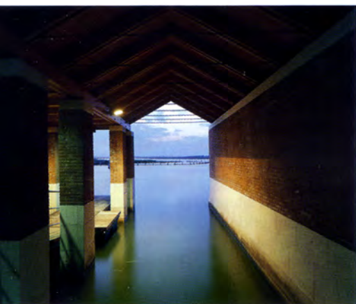
2. Vista interna di una delle cavane del terminal di primo soccorso
