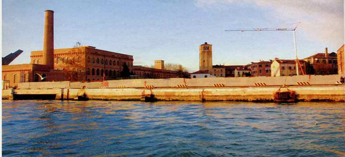
Sono appena stati demoliti i Magazzini Frigoriferi, si comincia a costruire la nuova sede dell'Istituto di architettura.
