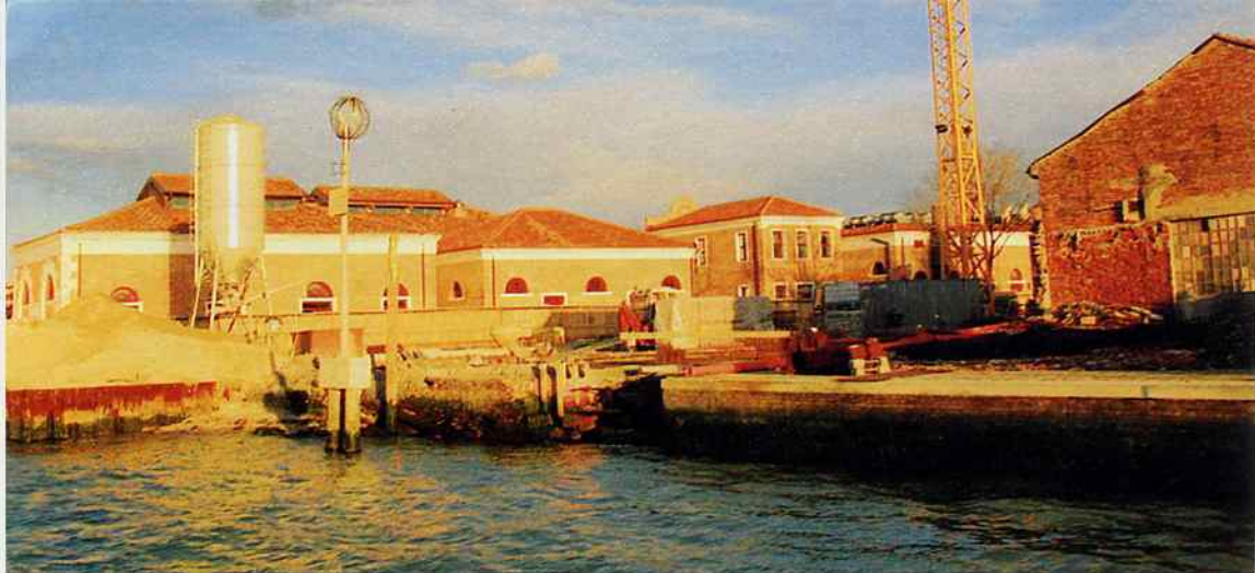
Acqua, sabbia e gru: la facoltà di Economia e commercio di Ca' Foscari si installerà dietro la stazione di Santa Lucia.
