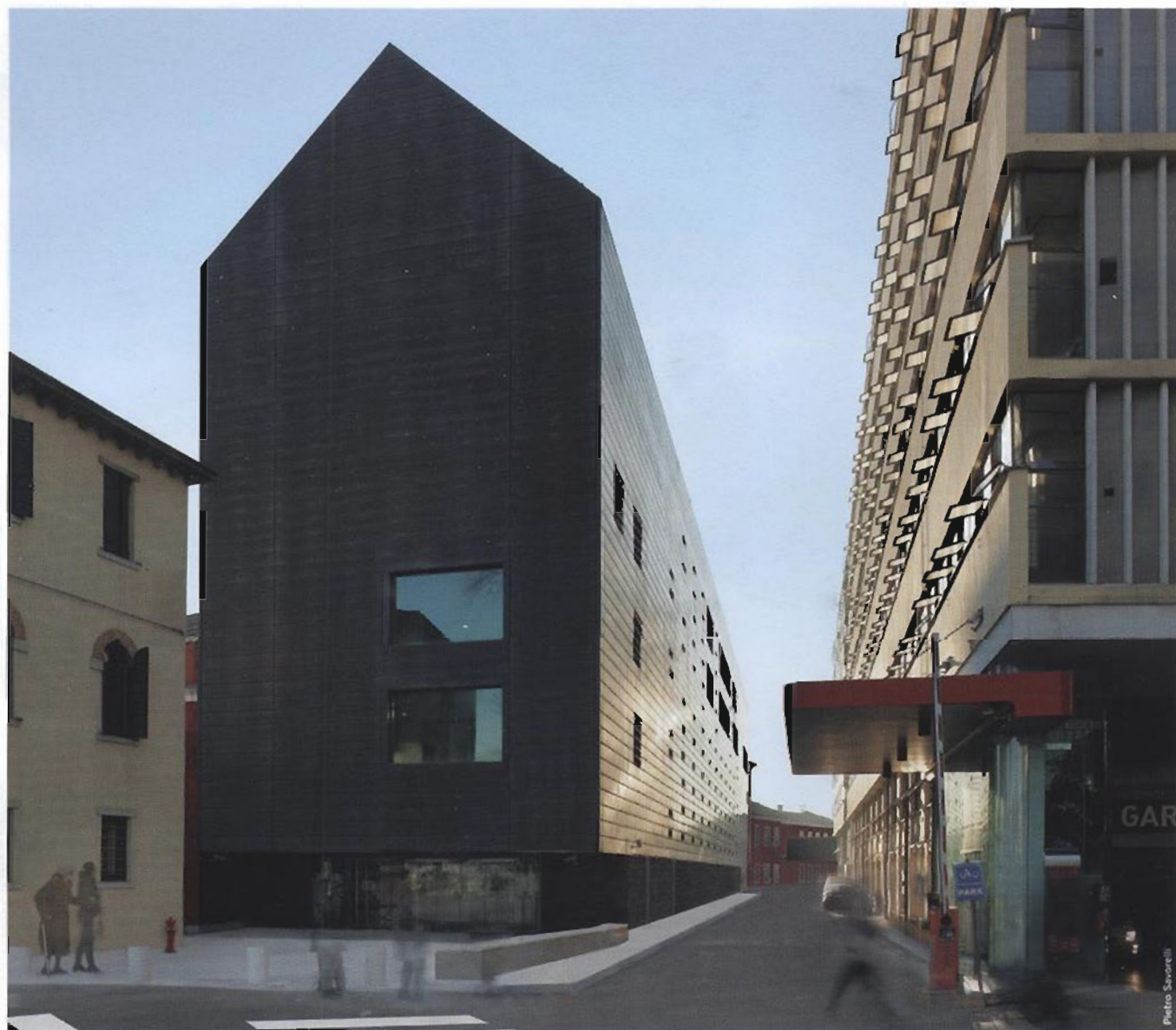
◀ Uno sbaizo di 5 metri identifica l'ingresso al nuovo volume A 5 meters overhang identifies the entrance to the new volume
