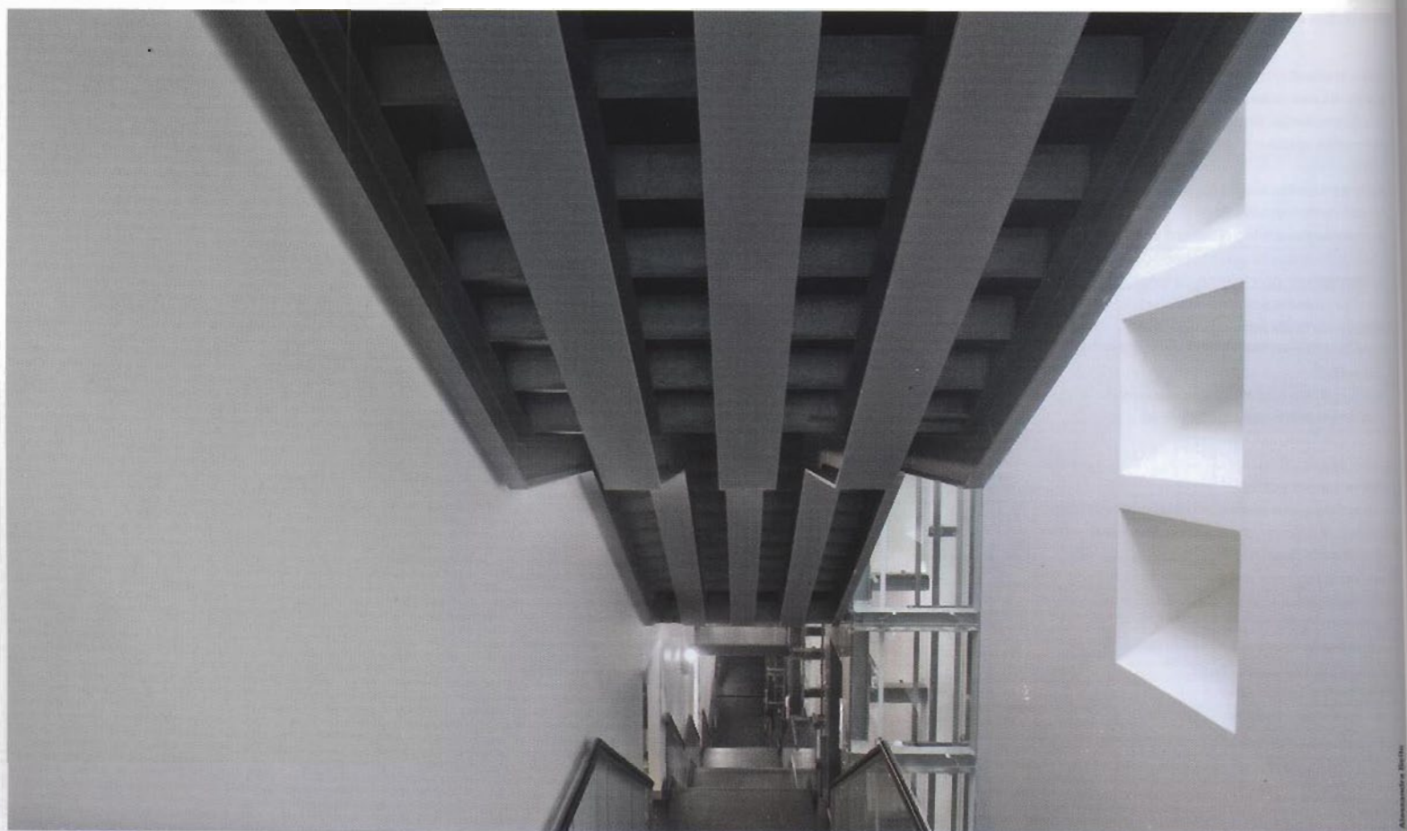
∪ Le nervature all'intradosso della scala interna The intrados ribs of the internal staircase
