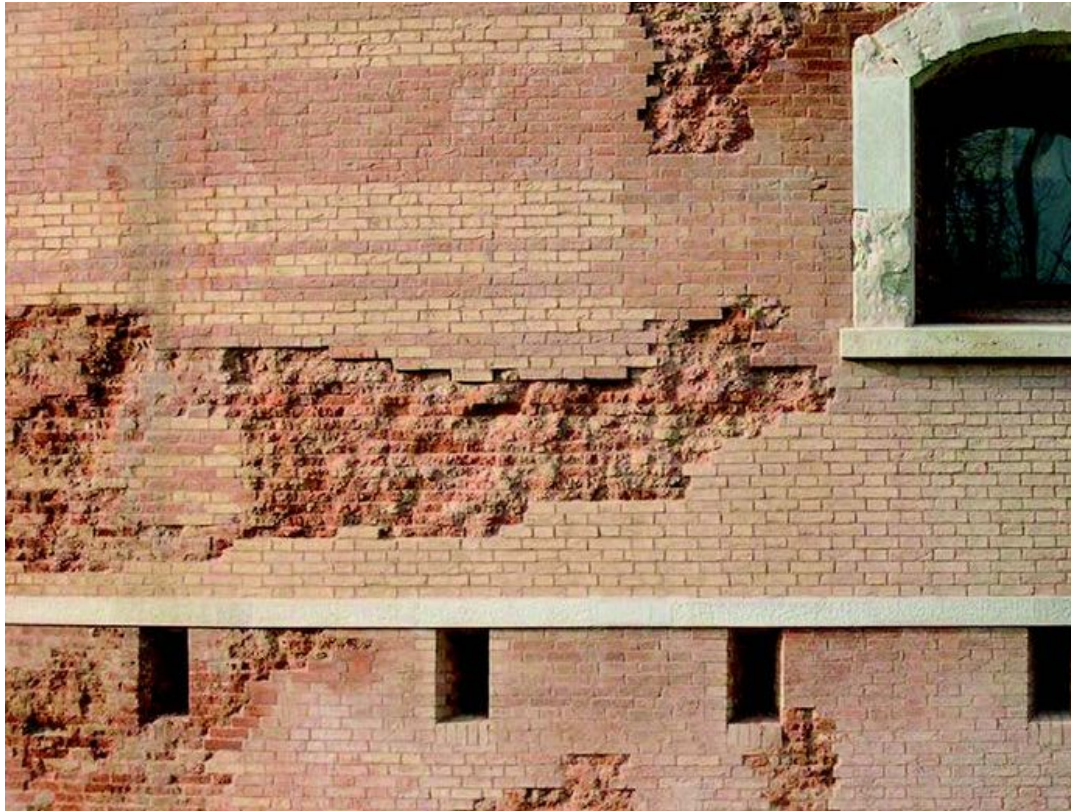
Torre Massimiliana, isola di Sant'Erasmus, Venezia. Dettaglio delle integrazioni murarie.
