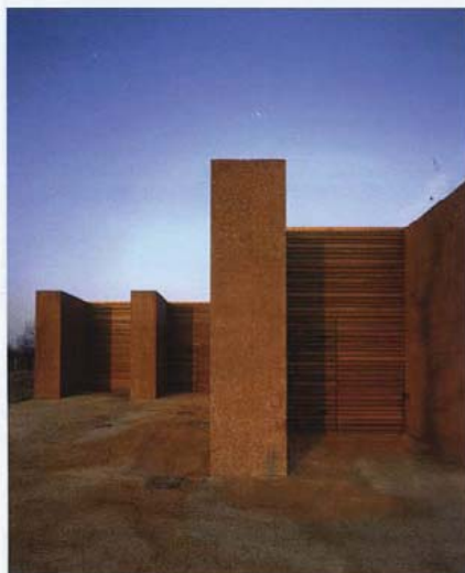
Isola di Sant'Erasmus, Venezia, depuratore, i muri in cemento armato colorato in pasta e disattivato dello spessore di un metro e, nella pagina precedente, in basso, i pannelli di iroko apribili per lo scarico delle polveri
