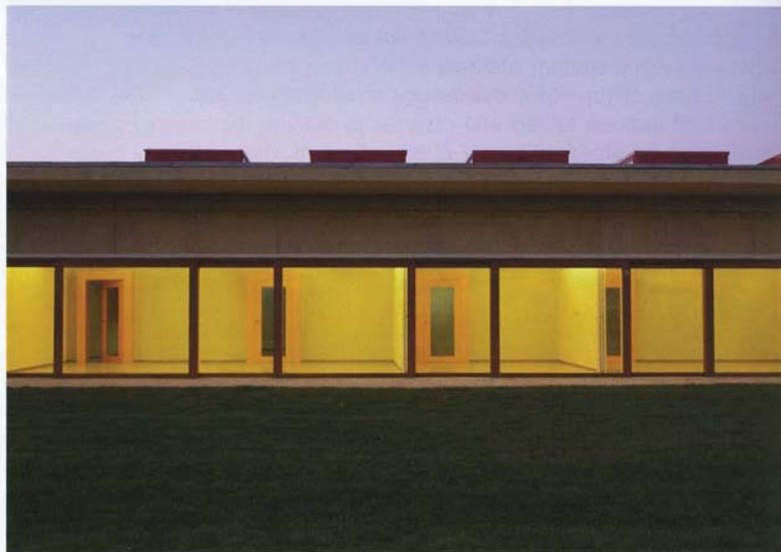
Isola di Sant'Erasmus, Venezia, depuratore, i muri in cemento armato colorato in pasta e disattivato dello spessore di un metro e, nella pagina precedente, in basso, i pannelli di iroko apribili per lo scarico delle polveri
