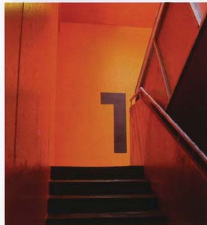
Conegliano, parcheggio interrato. In basso, vista interna, in alto vista interna di una delle uscite di sicurezza
