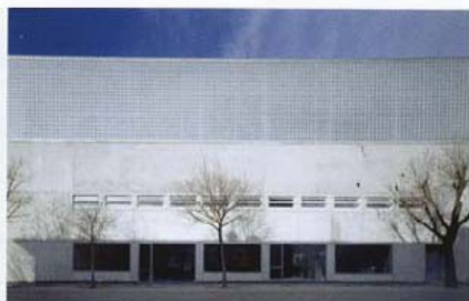
In alto, Novoli, Firenze, residenze universitarie e servizi, il fronte esterno delle sale studio verso via Fortanini, in basso il fronte interno delle sale studio
