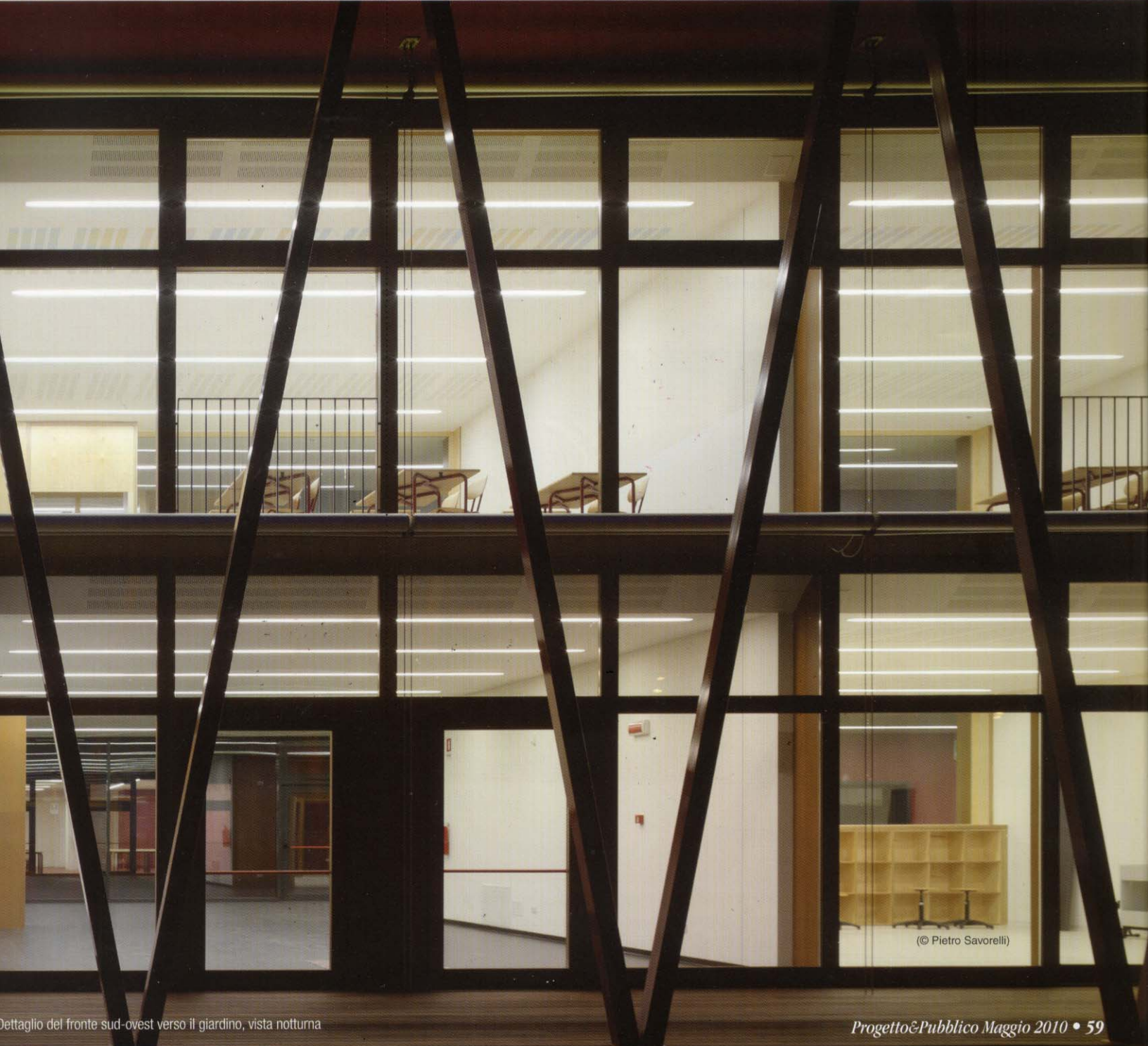
Dettaglio del fronte sud-ovest
