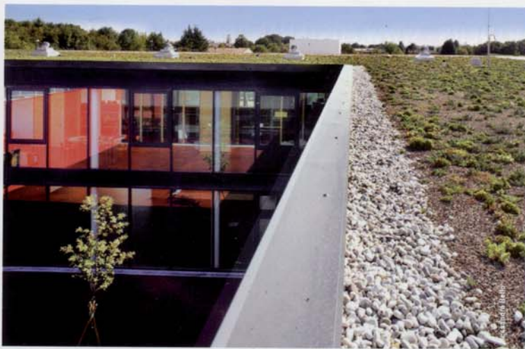
Il tetto verde e, sullo sfondo, gli estrattori eolici
